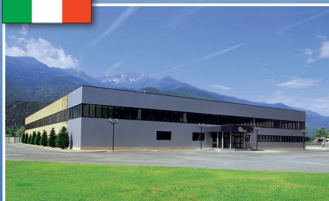
AUTOBLOK Werk in Caprie-Torino
