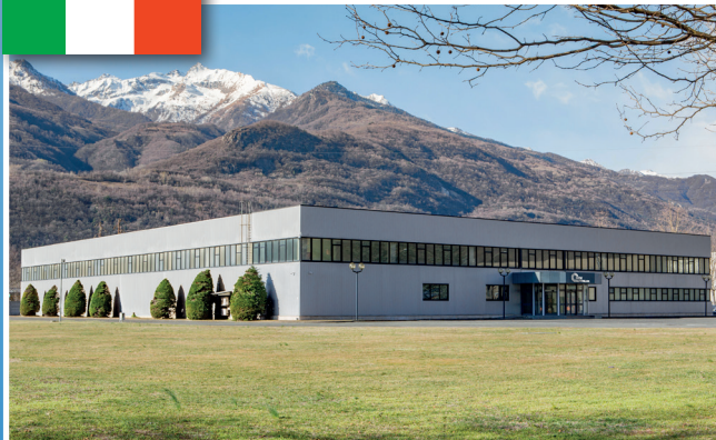
AUTOBLOK Werk in Caprie-Torino
