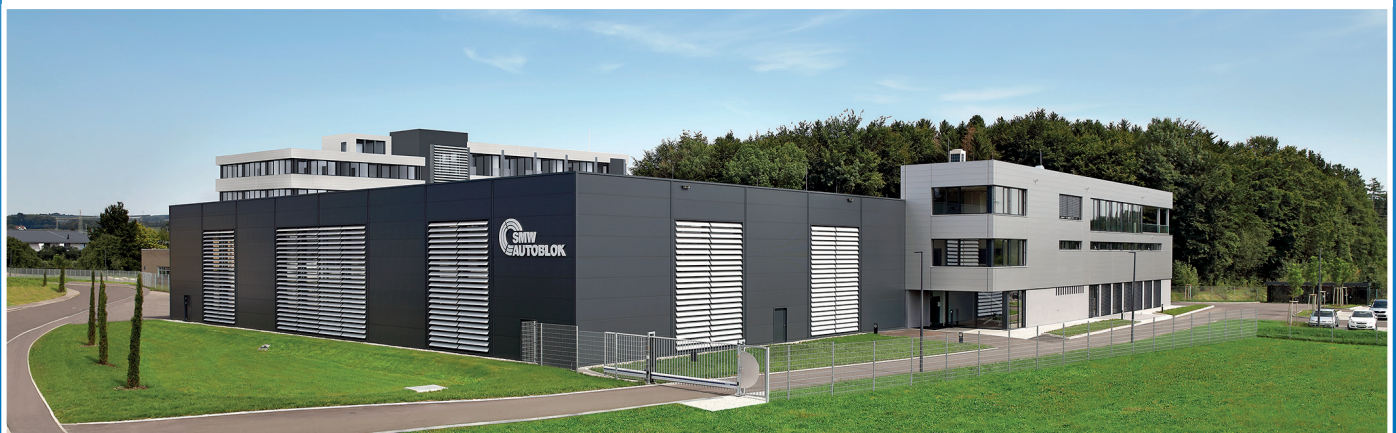
SMW-AUTOBLOK Technik- und Logistikzentrum Meckenbeuren
